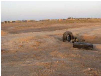
Figure 21 - Diguette construite en bordure de la rivière à Spartines pour protéger les cabanons des inondations.
