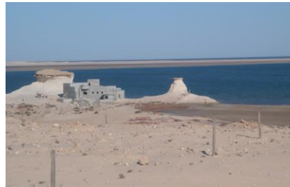
Figure 20 - Construction abandonnée au pied des champignons.
